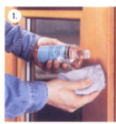
Sikkens Spezialreinger se nanáší hadříkem na dřevěné plochy, rozpouštěné nečistoty se setrou.
