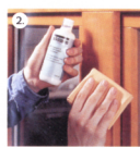
Přiloženou houbočkou (po použití vyprat ve vodě) se nanáší SIKKENS PFLEGMILCH. Přípravek se dále již nečistí.
